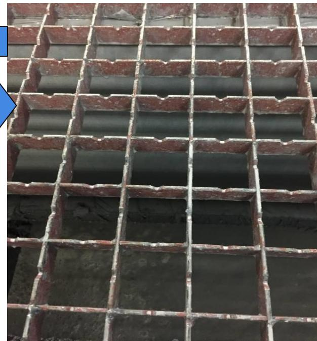
\* 剥離方法：超高压水洗（約700kg/m<sup>2</sup>）
